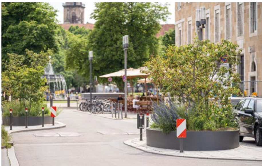
Städtebauliche Schutzlösungen als dauerhafte Absicherungsmaßnahmen für öffentliche Räume © Polizeiliche Kriminalprävention/Maik Goering
