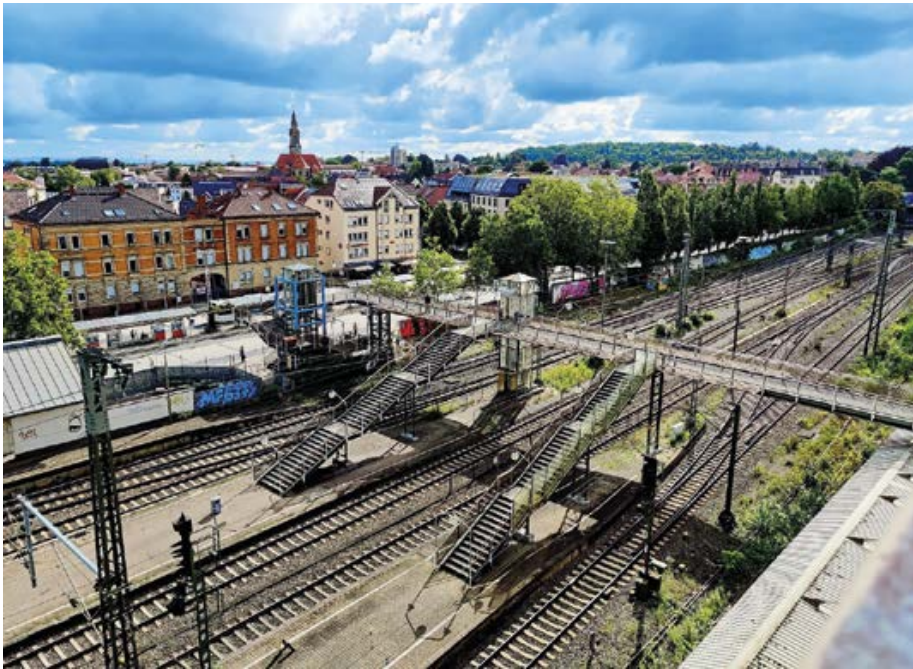
Gleisanlage und Franck-Steg
